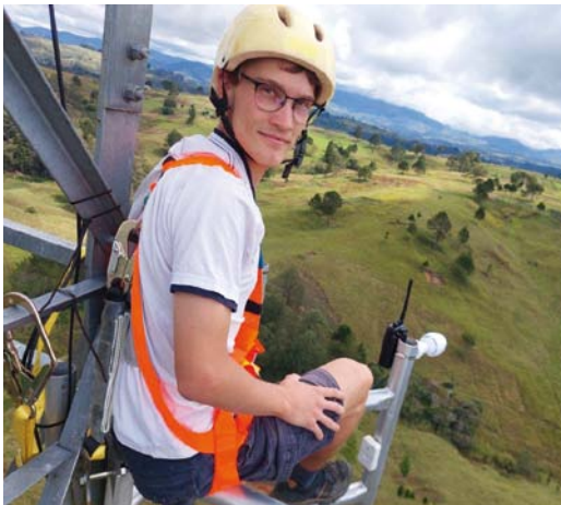
Joel bei der Wartung eines Radioturms
