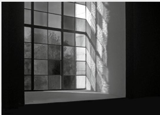
Wochen durch Folien simuliert. Die vorgesetzten Glasscheiben sind am Rand nicht luftdicht, sie werden ohne Fugendichtung in die Laibung eingepasst, sodass sie im Sommer wieder entfernt werden können. Laut Aussage der Experten tritt der gewünschte Effekt dennoch ein: Zwischen der alten Außenscheibe und der neuen Innenscheibe wird sich ein Luftpolster bilden, das den unangenehmen Walzeneffekt der von oben herunterfallenden, kalten Luft verringert.
