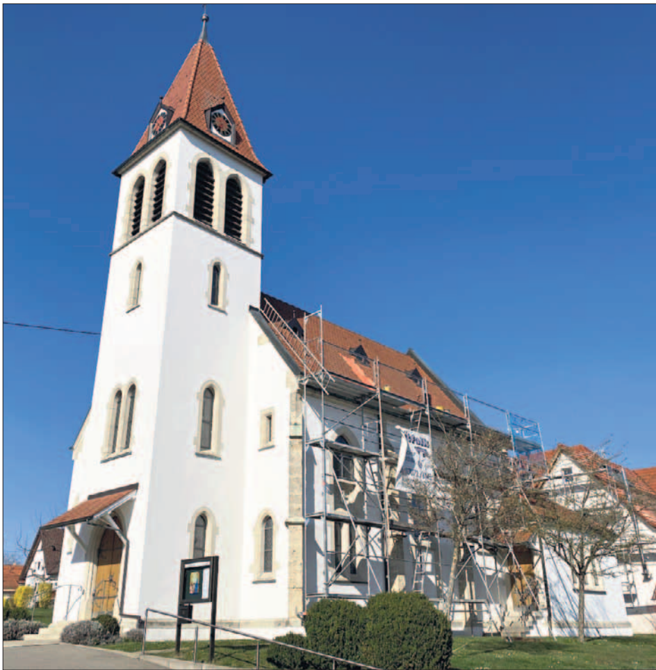
Von beiden Seiten ist das Langhaus der Kirche Stockach eingerüstet.
