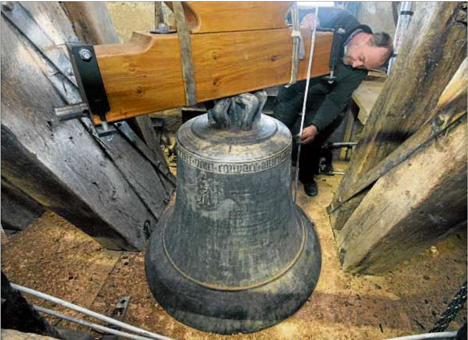
Zimmerermeister Elmar Seifermann misst die größte der drei Glocken aus. Sie hängt künftig an einem Holzjoch.
