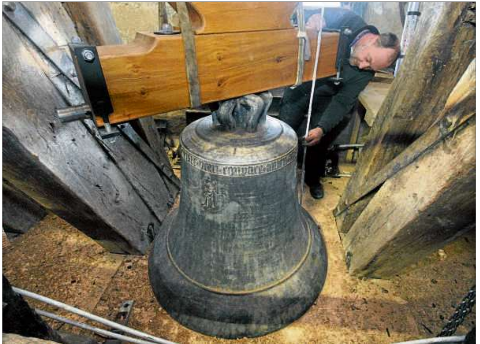
Zimmerermeister Elmar Seifermann misst die größte der drei Glocken aus. Sie hängt künftig an einem Holzjoch.
