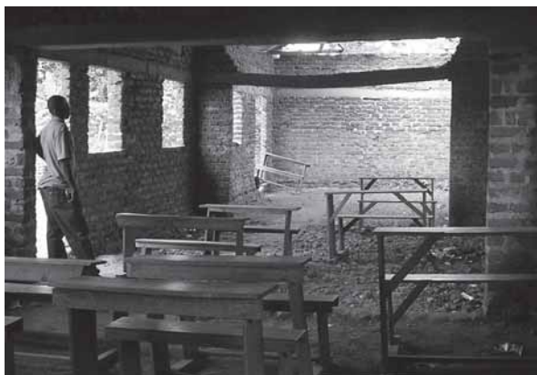
Derzeitiger Zustand des Gebäudes in Mafubira
